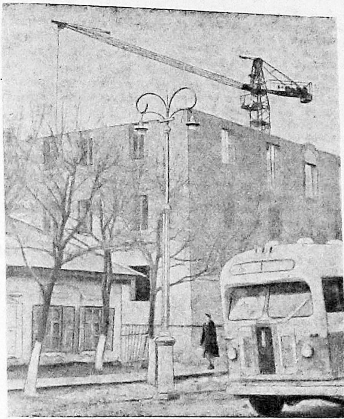
Строительство нового многоэтажного жилого дома на Некрасовской улице. Фото Е. Абзагуза.
